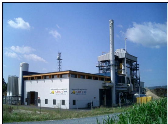
Abbildung 3-10: Biomasse – Heizkraftwerk Güssing
