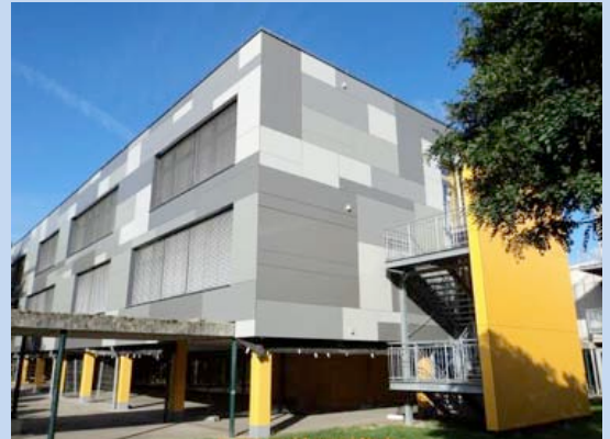
Altbausanierung eines Gymnasiums zum Passivhaus
