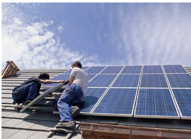
Installation einer Fotovoltaikanlage auf einem Hausdach
