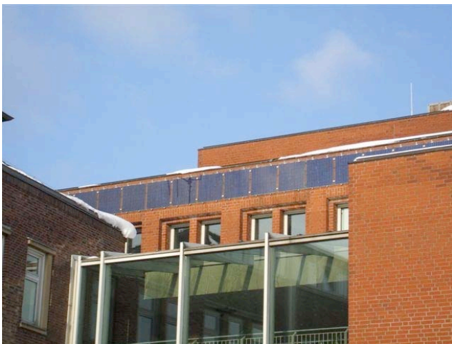
Photovoltaikanlagen auf dem Dach des Innenministeriums
