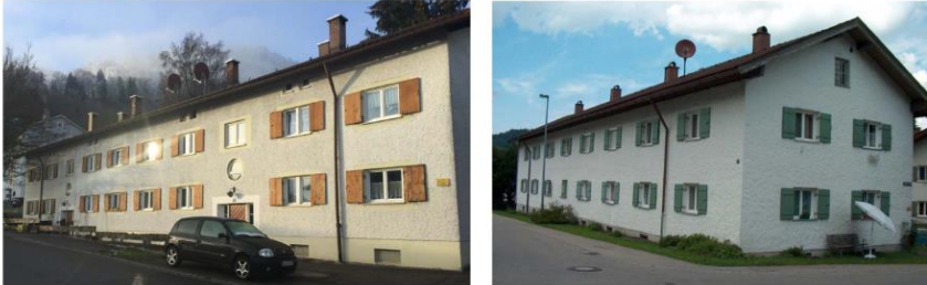
Abb. Bestandsgebäude, für die derzeit Ersatz geplant wird. Siedlerstraße 28/30 und Siedlerstraße 15/17 Konzepterstellung an Architekten beauftragt (siehe Anlagen), geplanter Baubeginn 2022
