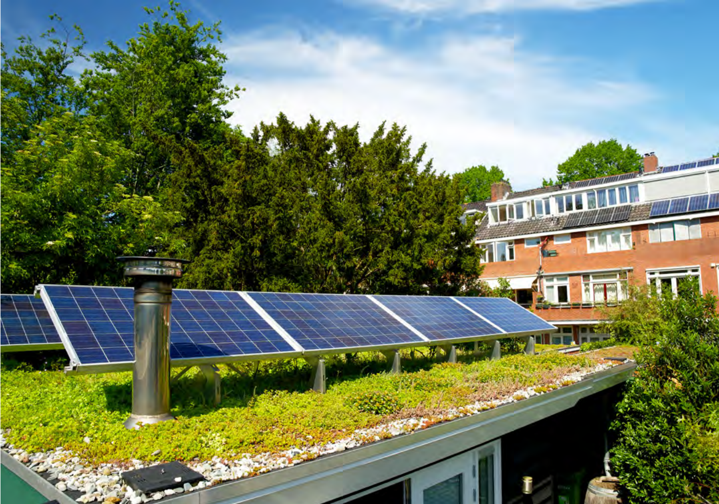
Solargründächer vereinen multiple Synergieeffekte: Sie mindern die Folgen von Starkregen, kühlen das lokale Mikroklima, erzeugen grünen Strom und halten die Dachhaut länger in stand.
